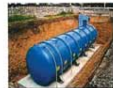
【耐震性貯水槽】
