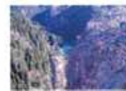
【能登半島地震における土砂ダムの例(輪島市市ノ瀬)】
