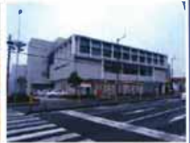
〈津波避難ビルとして指定されている高知東郵便局（高知市）〉
