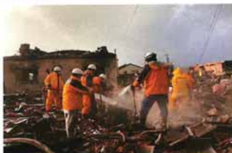
【輪島市消防団による消火活動の様子】
