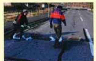
1月2日、輪島市門前町において、輪島市消防団が、道路の亀裂部分に土嚢を埋め、通行を可能とする応急対策を実施
